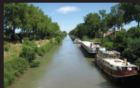
Fig. 46 : Le canal industriel, un espace habité
