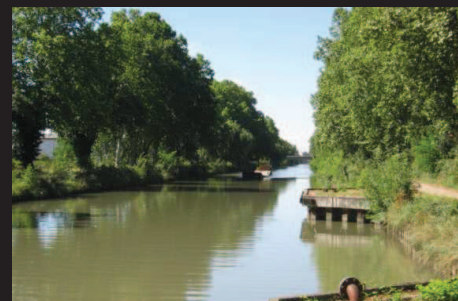
Fig. 47 : Un canal ouvert et dégagé
