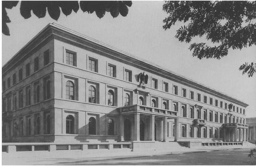
Führerbau à Munich. Bâtiments de l'administration du parti nazi - 1931 34
