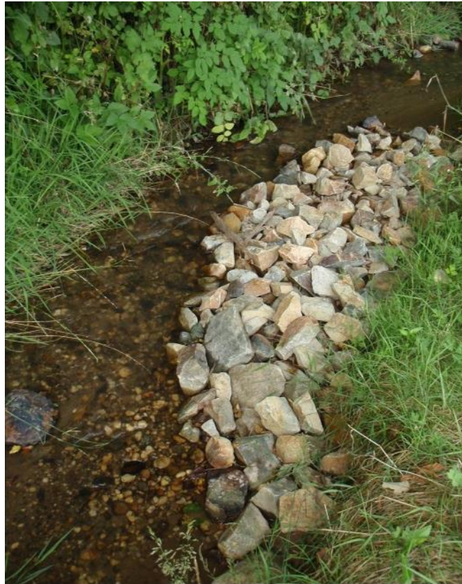
Figure 28 : Banquette en pierre sur une rivière du bassin de la Colmont (Photographie issue du site de la CCBM (17) )
