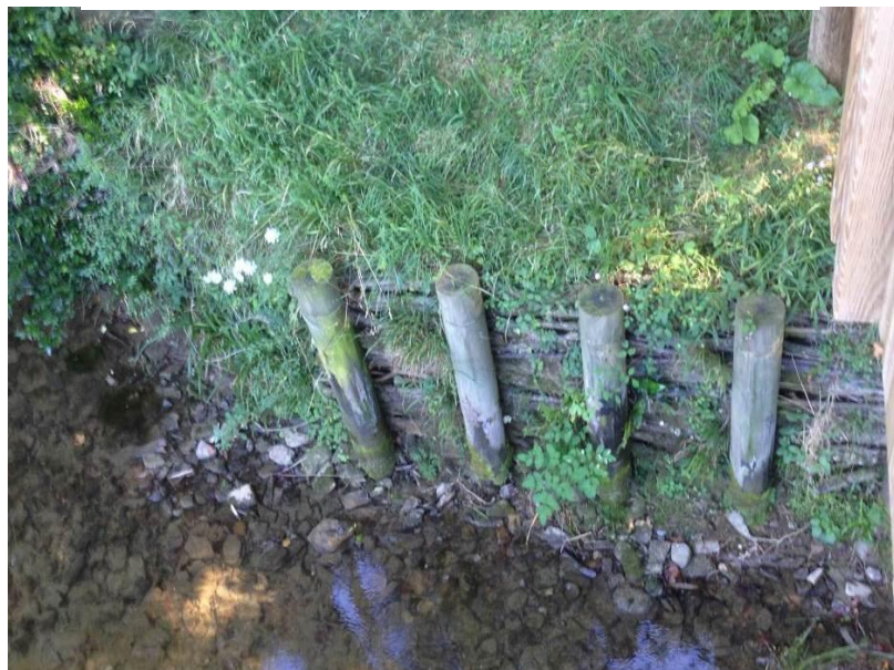
Figure 29 : Banquette végétalisée retenue par des pieux et tressage (2013, Pyrénées-Atlantiques, Amandine Lefèvre)
