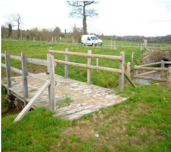
Figure 31 : Passerelle à bovins sur l'Oir (50) (photographie issue du site de la CCBM [17] )
