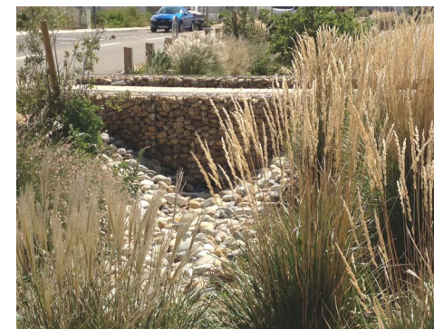
Figure 39 : Noue sèche à Maubec, Isère, (source : E. Boutot)
