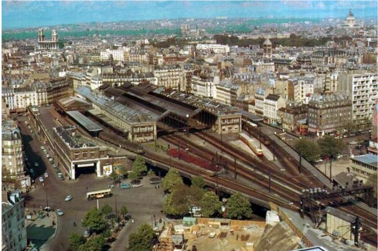
Figure 36 : Ancienne Gare Montparnasse, vue de derrière, années 1960 ?
