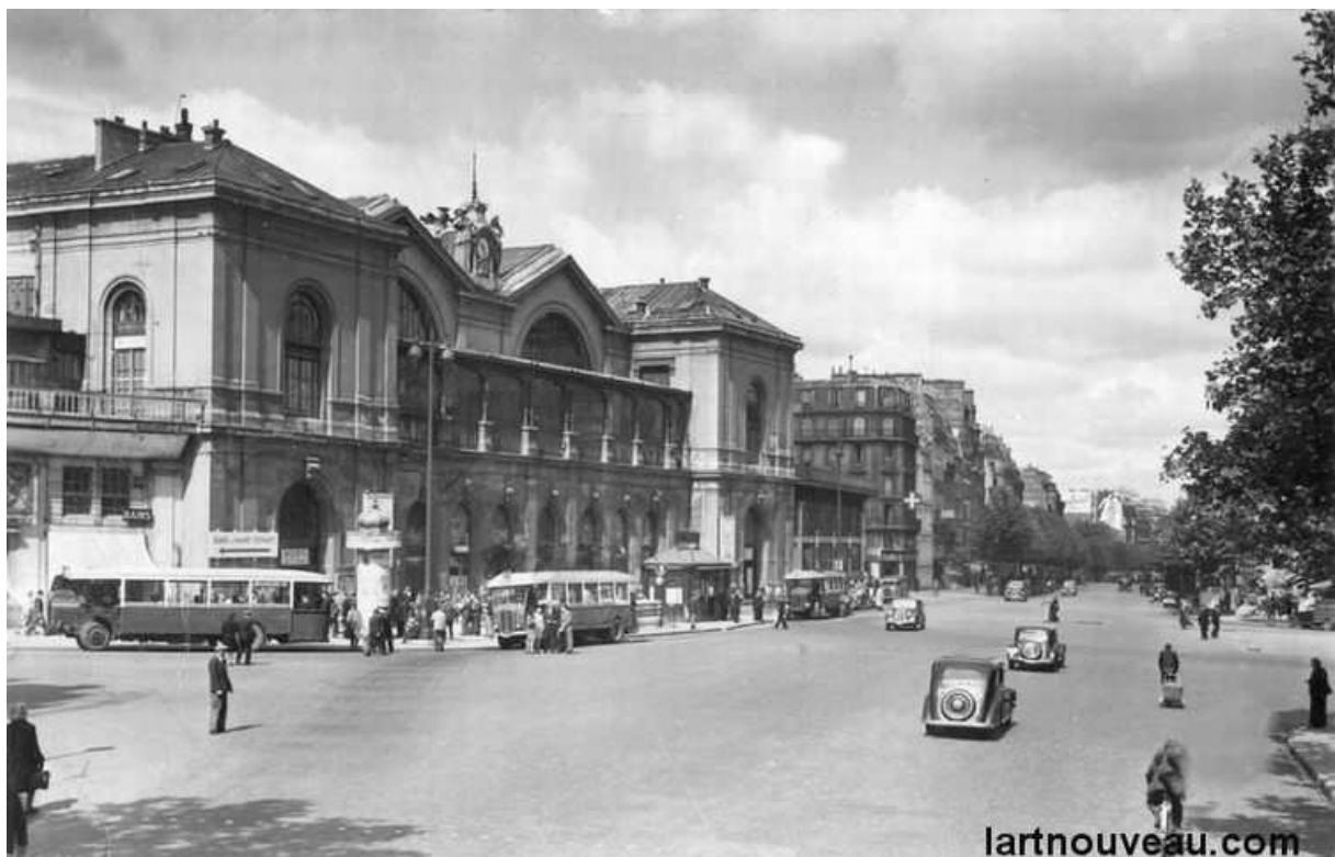
Figure 35 : Façade et parvis de l'ancienne Gare Montparnasse, années 1950
