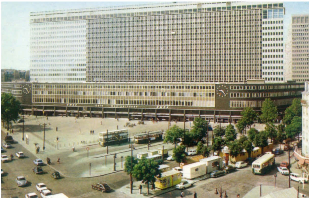
Figure 37 : La nouvelle Gare Montparnasse, années 1970
