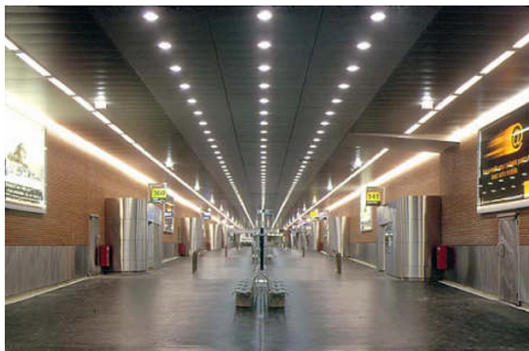
Figure 9 : Intérieur de la gare routière RATP, gare de départ - Source : www.gemo-paris.com
