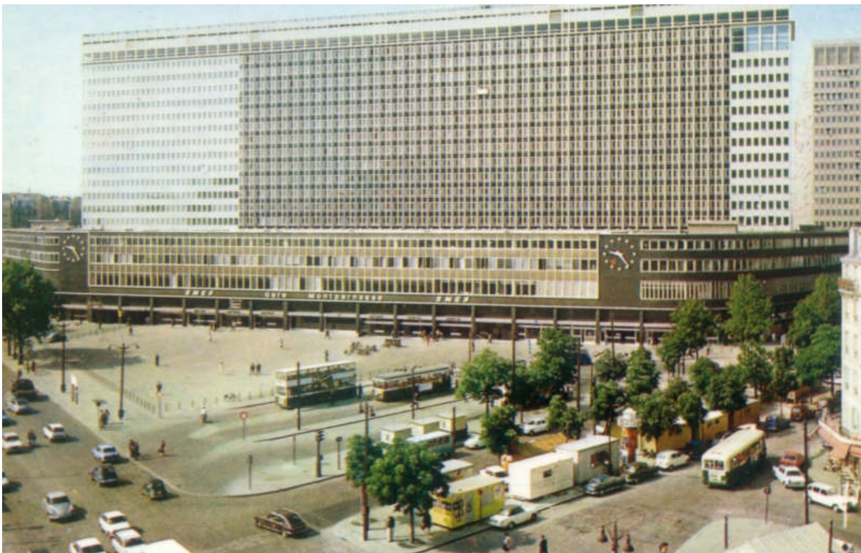
Figure 37 : La nouvelle Gare Montparnasse, années 1970
