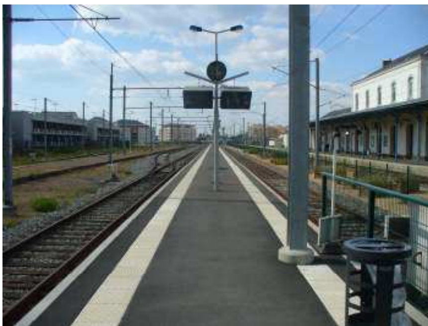
Figure n°16 : terminus de la ligne électrifiée en Gare des Sables d'Olonne 44
