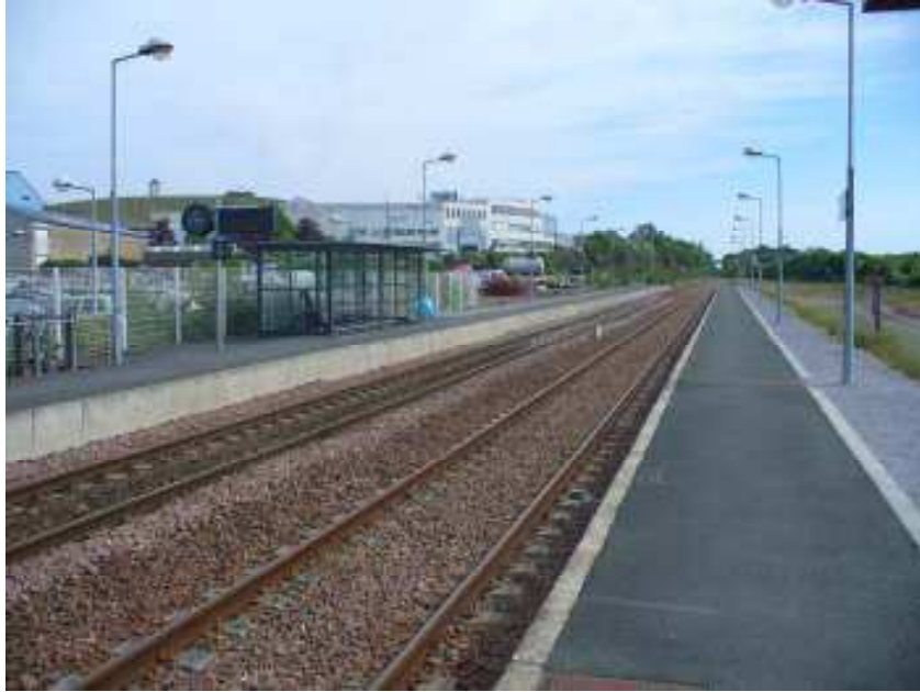
Figure n°13 : photo de la Gare de Chalonnès rénovée : quais, information voyageurs, parking pour les voitures particulières... 35
