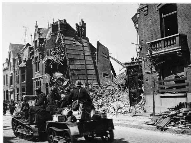
Traversée de Valenciennes en ruine
