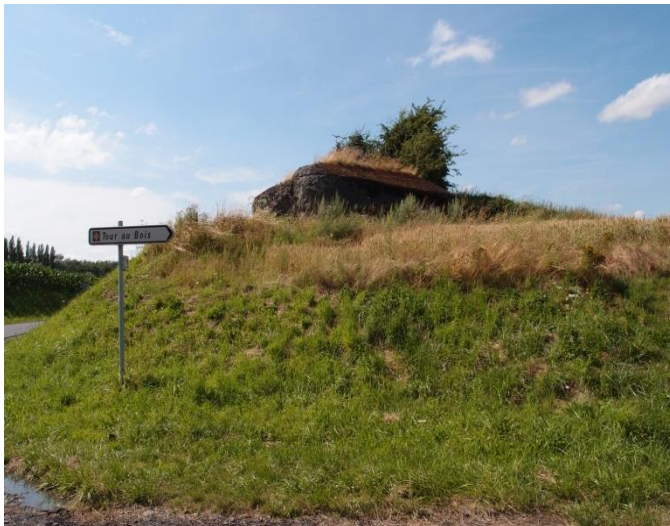
Blockhaus du Secteur Fortifié de Saint-Waast-la-vallée (le nord est à droite sur la photo)
