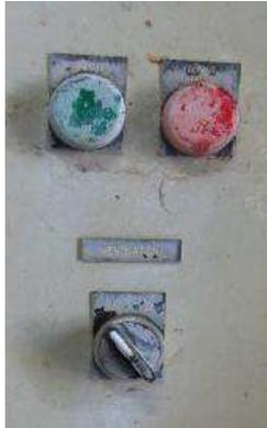
Figure 11 : dépôts calcaire sur la façade extérieur des armoires électriques (station de pompage de Laméjoul, 11/03/2013, V. Frizon de Lamotte)
