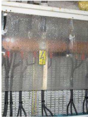
Figure 12 : condensation à l'intérieur des armoires électriques (station de pompage de Laméjoul, 11/03/2013, V. Frizon de Lamotte)
