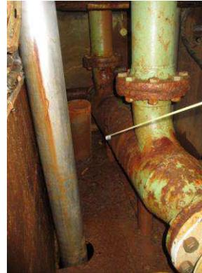
Figure 13 : oxydation de la canalisation principale (station de pompage de Laméjoul, 11/03/2013, V. Frizon de Lamotte)
