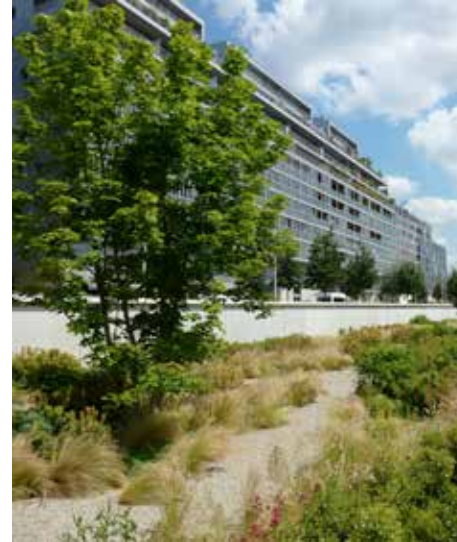
Figure 31 : Noue sèche au nord du Parc de Billancourt, Boulogne-Billancourt, crédits : J.Zub
