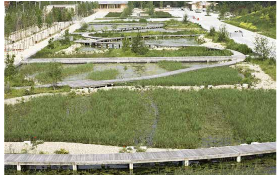
Figure 2 : les bassins d'épuration vus depuis la butte en haut du 7e bassin, crédits EPASA, Acanthe
