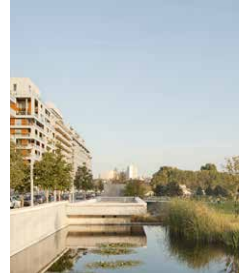
Figure 32 : Bordure en porte-à-faux au nord du Parc de Billancourt, Boulogne-Billancourt, crédits : Agence Ter
