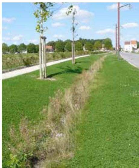
Figure 17 : Noue en bord de voirie, Arques, crédits : gestiondifferentiee.org
