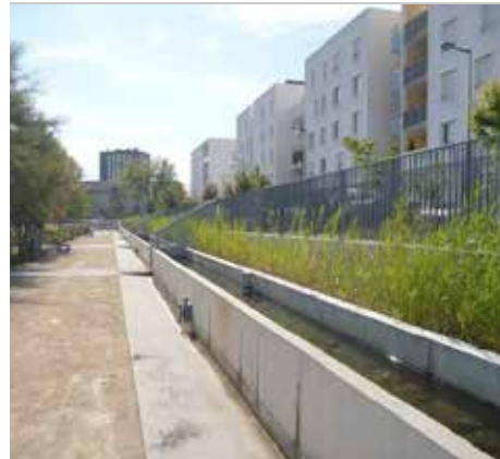
Figure 65 : Canal de filtration des eaux de ruissellement, Parc Ouagadougou, ZAC Teisseire, Grenoble, crédits : V.Giroud
