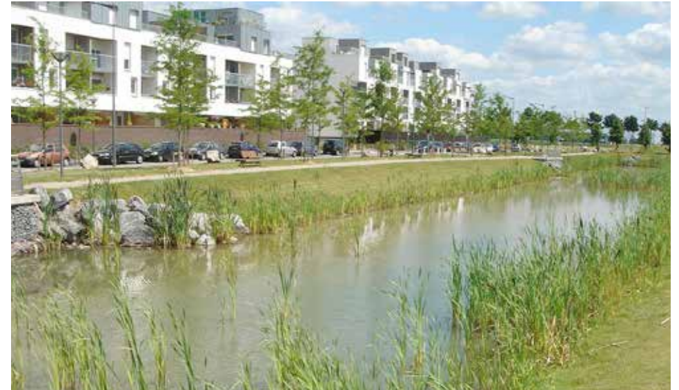
Figure 2 : Bassin de rétention ZAC de la Haute-Borne, Villeneuve d'Ascq, crédits : Atelier LD
