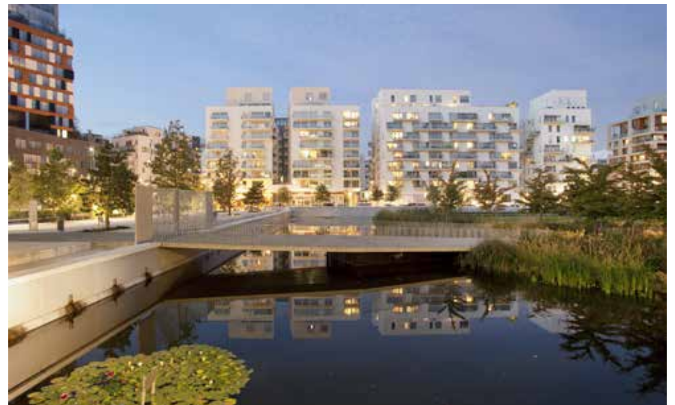
Figure 5 : Entrée principale du cours de l'île Seguin , crédits : Agence Ter
