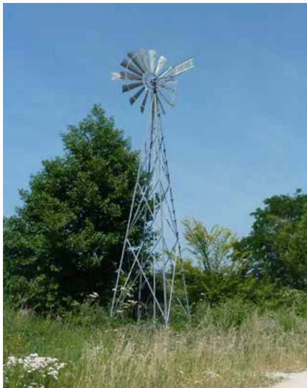
Figure 1 : éolienne servant à pomper l'eau du jardin des Touradons jusqu'aux jardins familiaux, crédits : J.Zub
