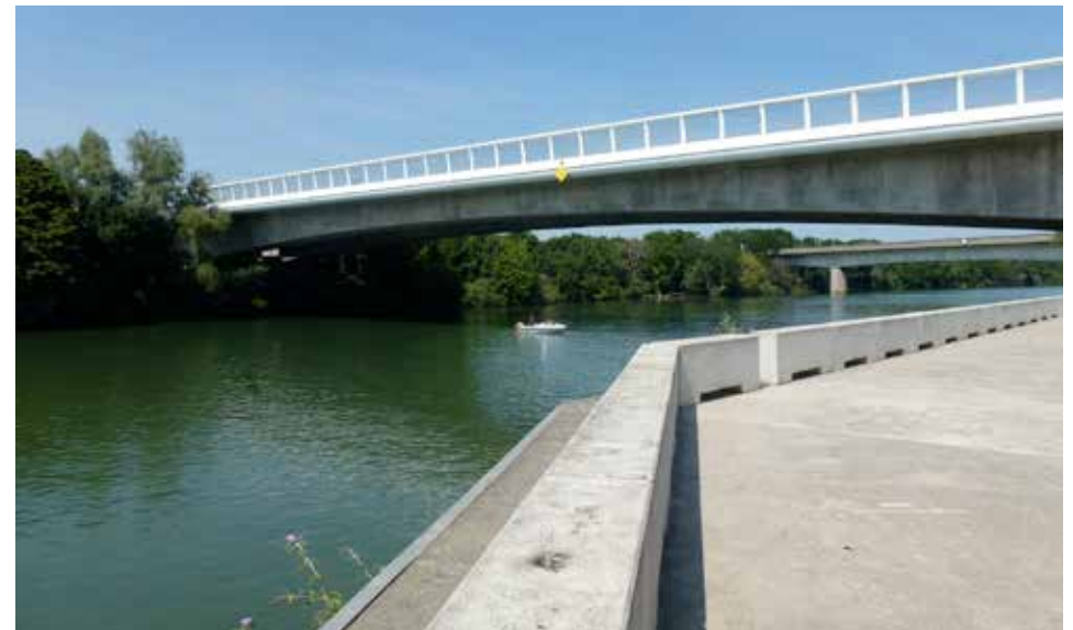
Figure 3 : La Seine et les ouvrages d'art supportant l'autoroute et le RER A, crédits : J.Zub
