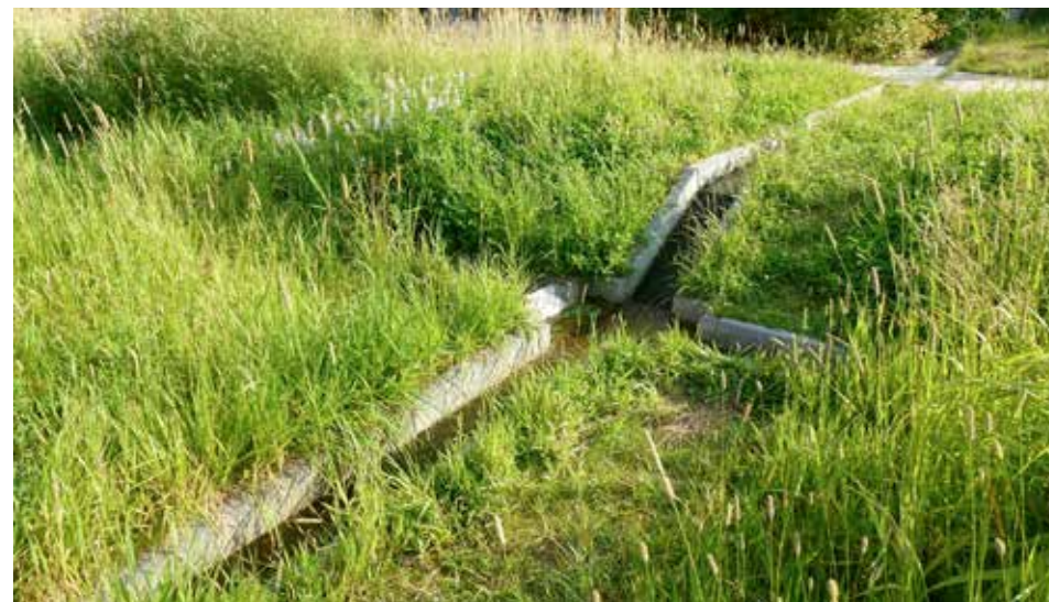
Figure 22 : Réseau de rigoles dans les Carrés Nomades, Parc des Grands Moulins, Paris XIIIe, crédits : J.Zub
