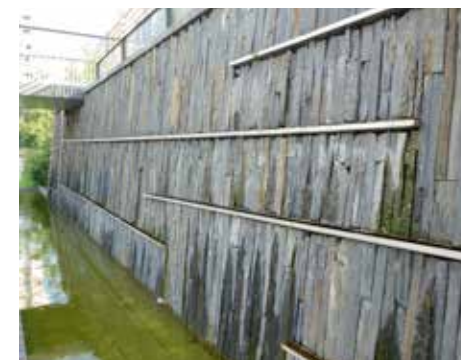
Figure 44 : Mur des Pluies, Parc des Grands Moulins, Paris XIII, crédits : J.Zub
