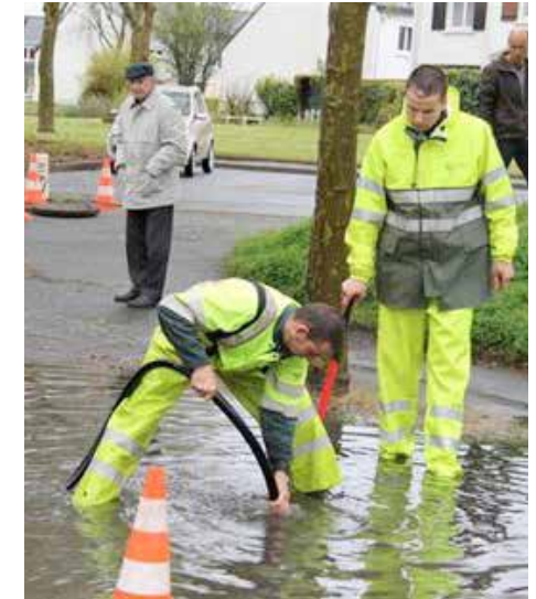
Figure 15 : travaux de débouchage d'un réseau d'assainissement, crédits : Ouest-France
