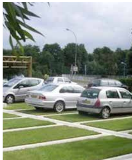
Figure 18 : Parking végétalisé drainant, Lauterbourg, crédits : ecovégétal
