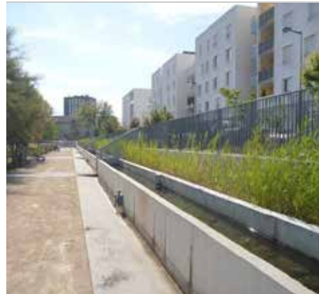
Figure 65 : Canal de filtration des eaux de ruissellement, Parc Ouagadougou, ZAC Teisseire, Grenoble, crédits : V.Giroud
