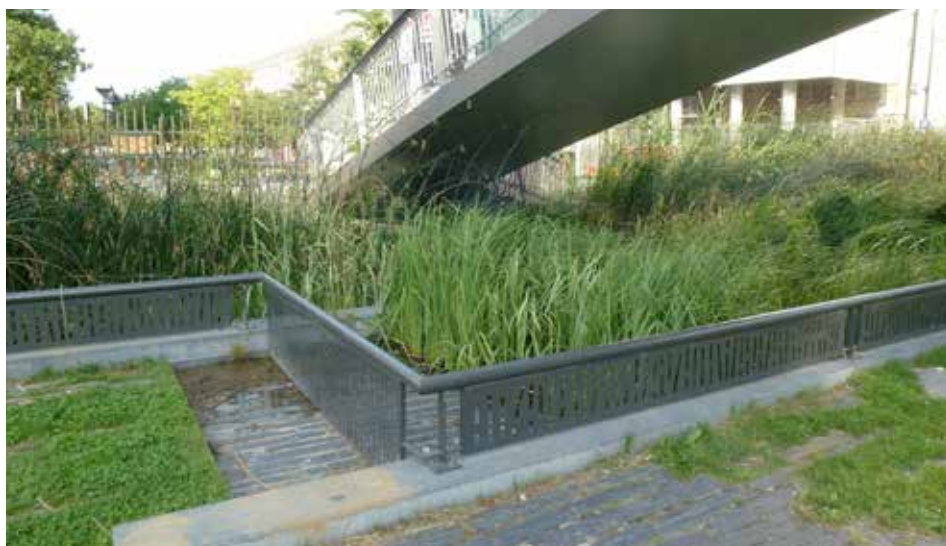
Figure 23 : Bassin planté, Parc des Grands Moulins, Paris XIIIe, crédits : J.Zub
