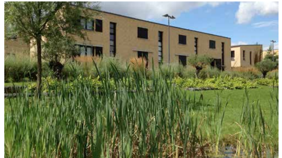
Figure 3 : Square inondable, ZAC de la Haute-Borne, Villeneuve d'Ascq, crédits : Atelier LD
