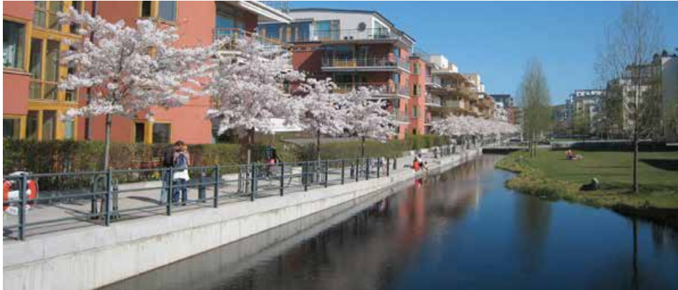
Figure 1 : Canal dans le parc Sjöstadsparterren, Hammarby, crédits : guide-stockholm.fr
