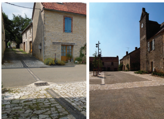
Fig. 29 : photographie - marquage du plan en damier de la Bastide de Beauregard par un pavage en pierres du causse.
