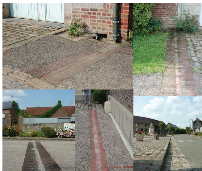
Fig. 30 : photographies - une alternance de matériaux et de techniques de pauses souligne le circuit de l'eau - Ribemont-sur-Ancre.
