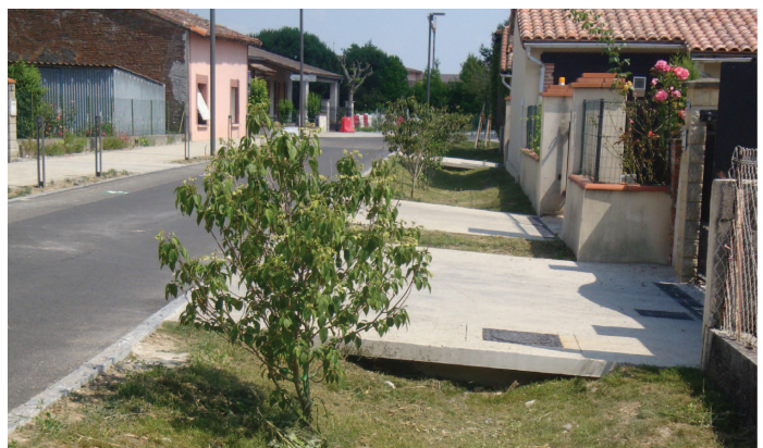
Fig. 41 : accès aux seuils de maisons par une dalle béton permettant le passage au dessus de la noue végétale
