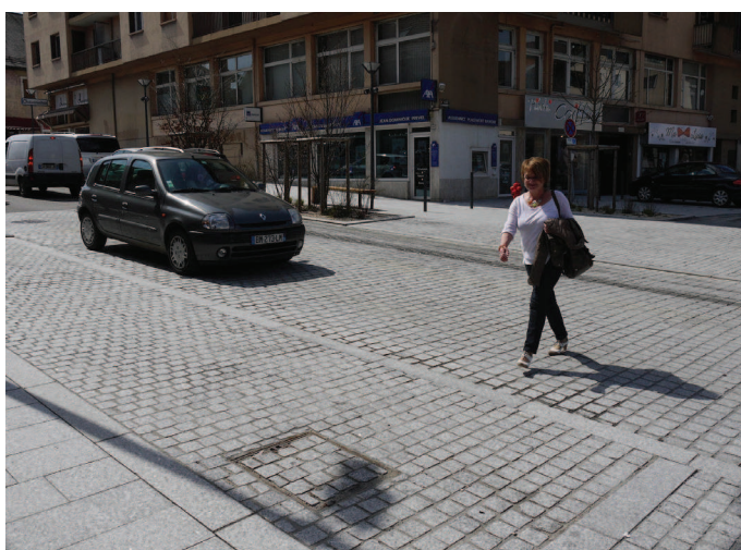
Fig. 22 : photographie : un plateau traversant en granit donne la priorité au piéton - Cruseilles . Source : Atelier UO , 2013.
