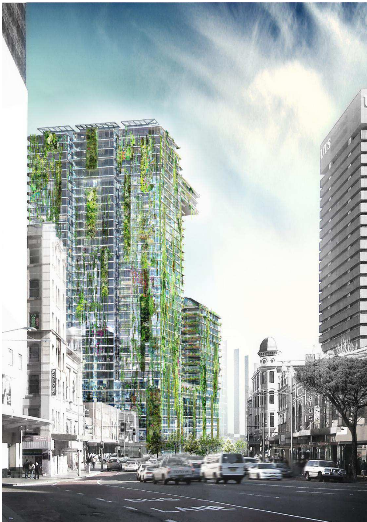
Figure 12 : Façade aux grimpantes de la tour de Frasers Broadway à Sydney. (Crédits : Ateliers Jean Nouvel)
