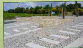
Aménagements minéraux sur des gratoires d'entrée de villes
