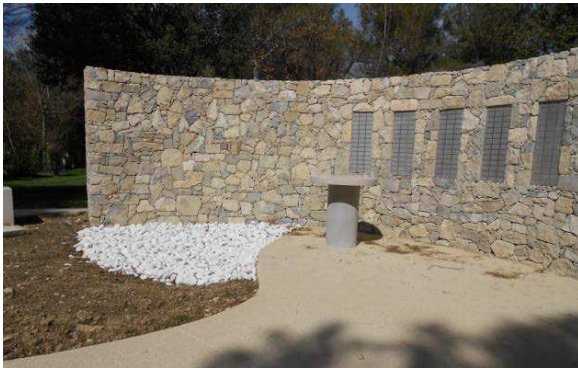
Figure 27 : le calcaire en construction
