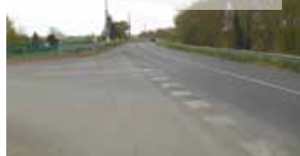
Sortie du pont vers St-Mathurin
