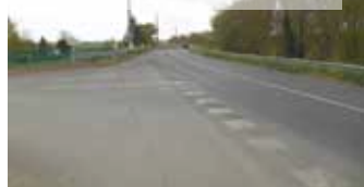
Sortie du pont vers St-Mathurin
