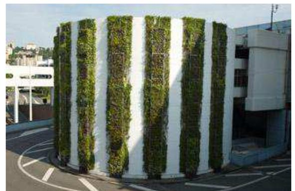
FIGURE 8 : MUR BIO-FILTRANT A LYON PERRACHE, SOURCE : [HTTP://WWW.LYON.FR](http://www.lyon.fr)
