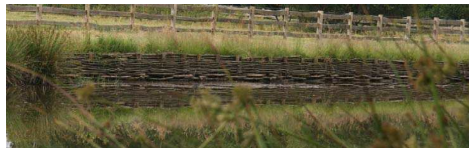
Un autre traitement des rives possible par structure en bois plessé, bassin du parc de St-Jacques de la Lande (source : C. Laurent)
