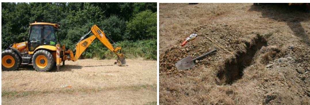
Figure 32 : Réalisation d'une fosse pour une analyse de sol (source : C. Laurent)
