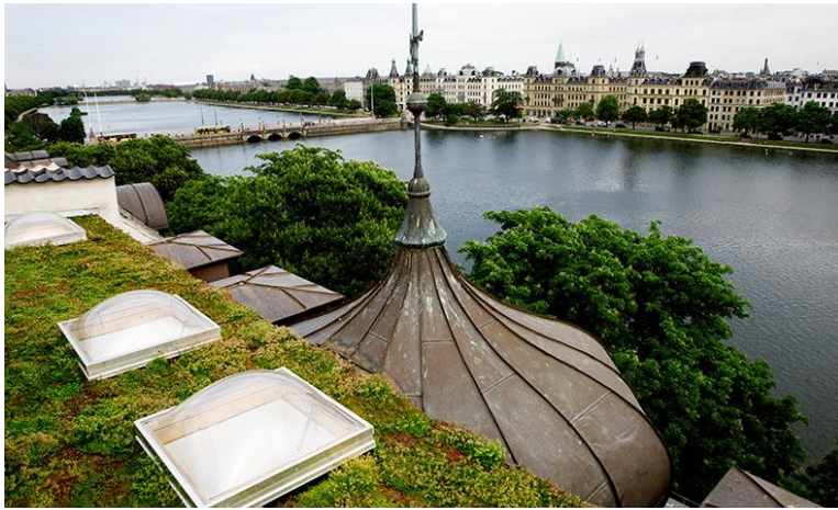
Figure 13- Toiture végétalisée, un habitat alternatif en milieu urbain, d'auteur anonyme [18]
