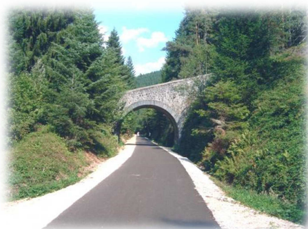
Figure 25: Revêtement en enrobé avec accotements en stabilisé ©OT Montfaucon, AF3V
