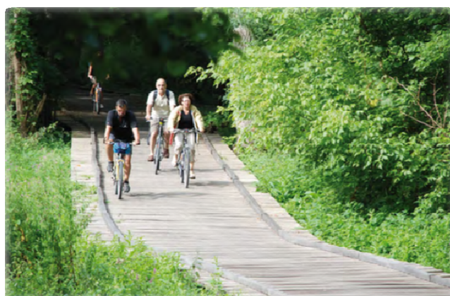
Aménagement Voie Verte en zones humides (platelage bois) dans le marais poitevin
