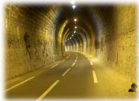
Figure 28: Tunnel sur la voie verte du lac d'Annecy © Luc Beeusaert, af3v.org
