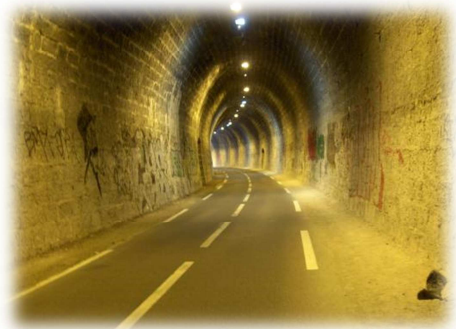
Figure 28: Tunnel sur la voie verte du lac d'Annecy © Luc Beeusaert, af3v.org
