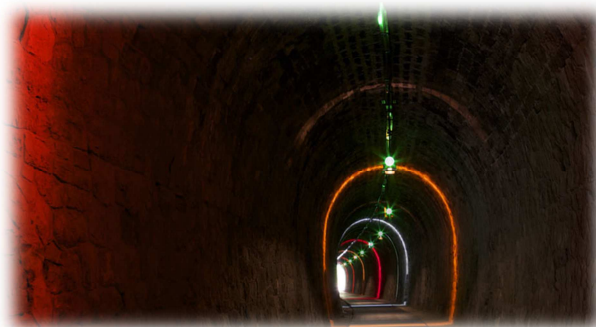
Figure 27: Tunnel du Vigan dans le Gard © Atelier Lumière, lemoniteur.fr
