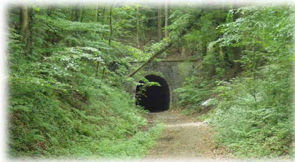
Figure 19: Entrée Nord du tunnel de Triollière devenu tunnel de Laumière (300m) © Alban DOUSSON, SEM
