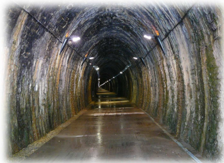
Figure 26: Tunnel du Bois Clair entre Cluny et Mâcon © Lyon Historique
