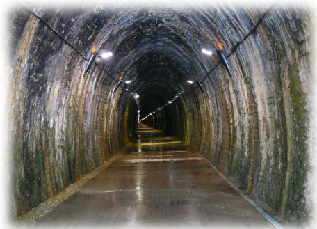
Figure 26: Tunnel du Bois Clair entre Cluny et Mâcon © Lyon Historique
