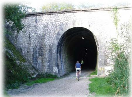
Figure 23 : Entrée en stabilisé du tunnel à Laroque-d'Olmes © J. Savary, AF3V
