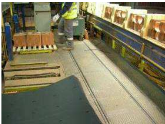
Fig. 13.A : opération de resserrage au sol
