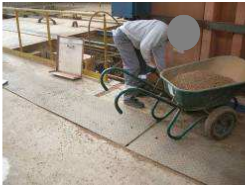
Figure 3 : Récupération du sable dans la goulotte de sortie
