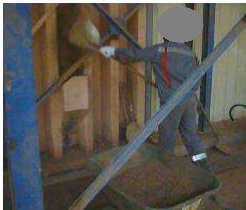
Figure 5 : Remplissage des goulottes d'alimentation
