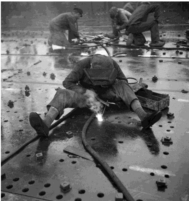
Kollar François, Dans le port, à bord. Super Ile de France : cisailage au chalumeau oxydrique (Société des chantiers et ateliers de Saint-Nazaire Penhoët), Saint-Nazaire (Loire-Atlantique), 1931.
