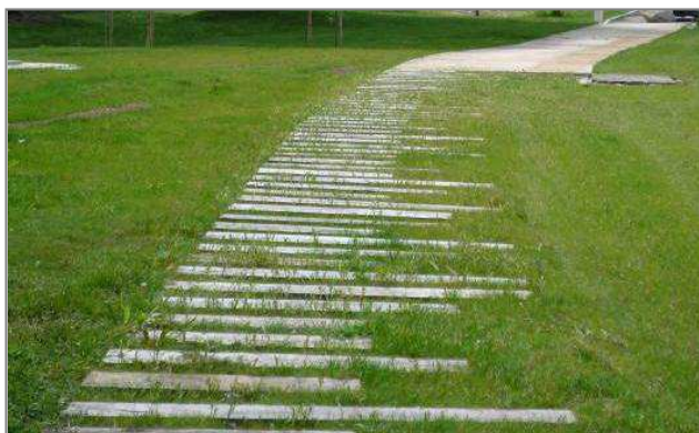
Figure 26 Photographie du cheminement avec traverses bois (Agence ENET-DOLOWY, 2013)
