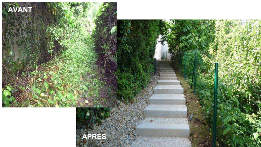
Figure 29 Photographie de l'escalier sur cheminement (Agence ENET-DOLOWY, 2007-2013)
