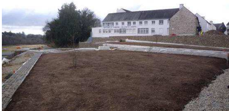
Figure 21 Photographie des terrassements à l'arrière de l'école St-Joseph (Agence ENET-DOLOWY, 2011)
