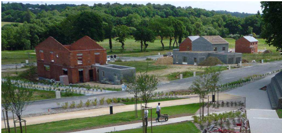
Figure 34 Photographie des premières constructions de maison, ZAC de Lenn Sec'h (Agence ENET-DOLOWY, 2013)
