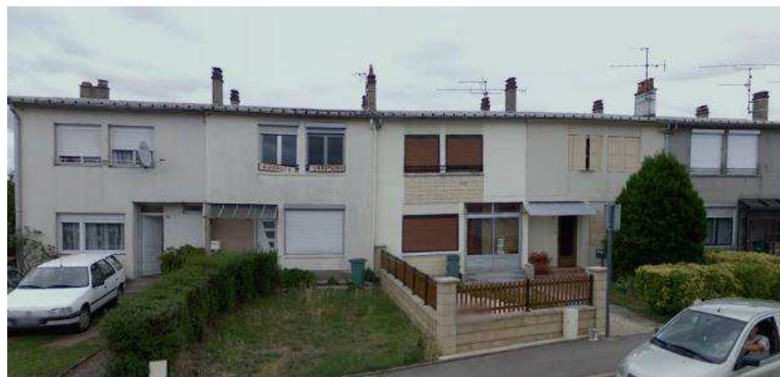
Figure 8 Les pavillons mitoyens du lotissement des Ensanges, Tomblaine (GOOGLE MAPS, 2013) [9]
