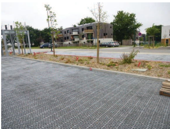
Fig. 11 a : Structure en nid d'abeilles (Source : Luc TESSIER) 9
