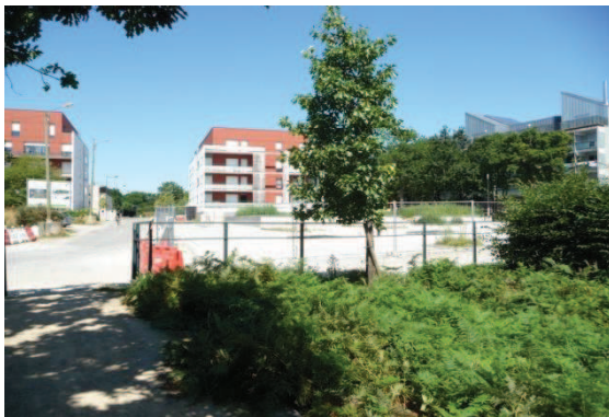
Fig. 29 : Place minérale en construction (Source Luc TESSIER)
