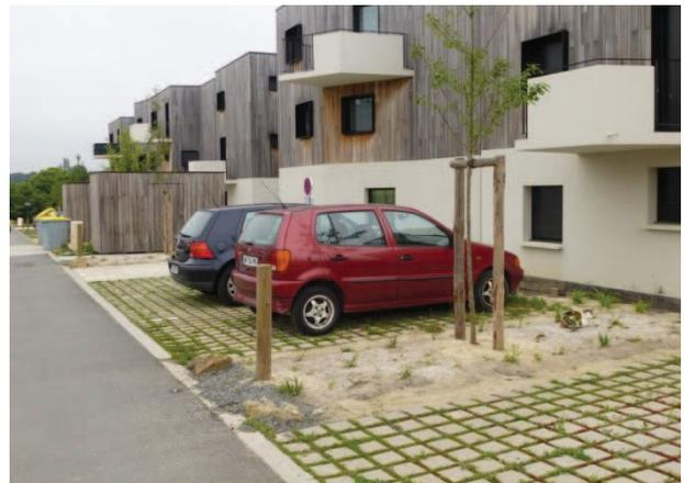
Fig. 11 b : Pavés joints gazon (Source : Luc TESSIER)
