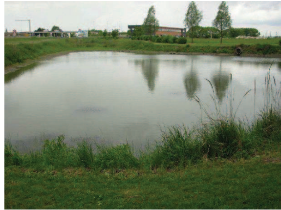
Fig. 16 c : Bassin en eau au parc d'activités des Près Loribes (59)
