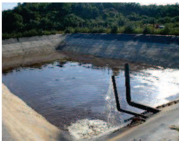
Fig. 2 : Photo d'un bassin d'orage (Source : www.eauvergnat.fr )
