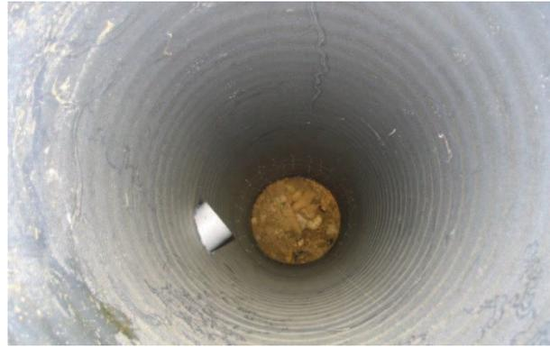
Fig. 10 : Puits d'infiltration (Source : <http://legoenpaille.free.fr>)
