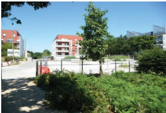
Fig. 29 : Place minérale en construction (Source Luc TESSIER)
