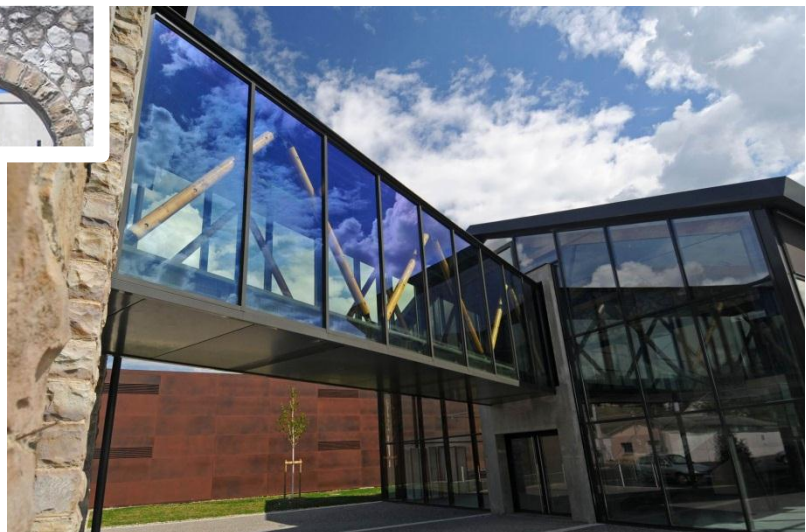
Figure 7 : Passerelle en métal et en verre, 2010, coll. D. Guilhamassé
