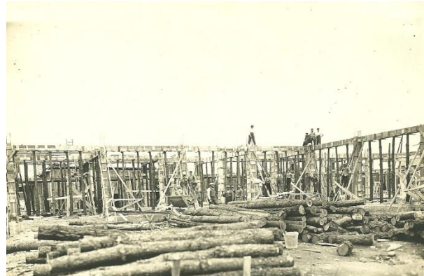
Figure 1: Pau - construction de l'Usine des Tramways, 1900, carte postale, coll. Jean-Louis Maffre
