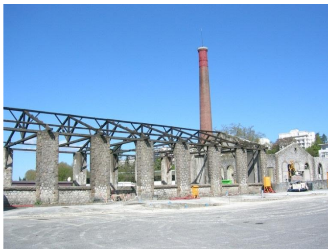
Figure 4 : L'Usine des Tramways pendant les travaux, 13/04/2008, Archives communautaires Pau-Pyrénées
