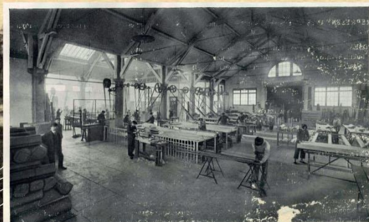
Usine de Pau, bâtiment C. Partie MENUISERIE et MONTAGE
