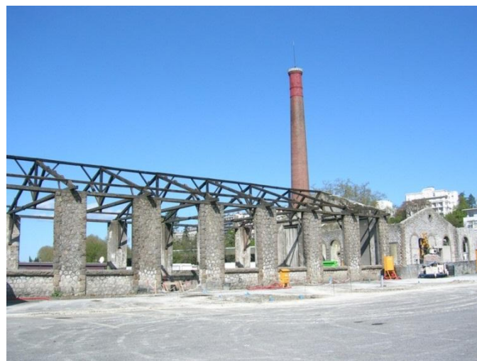
Figure 4 : L'Usine des Tramways pendant les travaux, 13/04/2008, Archives communautaires Pau-Pyrénées
