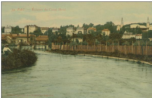
Figure 31 : Pau, Écluses du canal Heid, [avant 1916], Archives communautaires Pau-Pyrénées, 16Fi21
