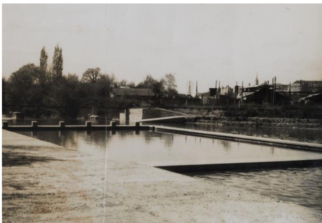
Figure 26 : La piscine du Coy, vue en noir & blanc des bassins extérieurs, photographie noir et blanc, auteurs Pyrenea-Sports, vers 1951, Archives communautaires Pau-Pyrénées, 2 Fi 1234
