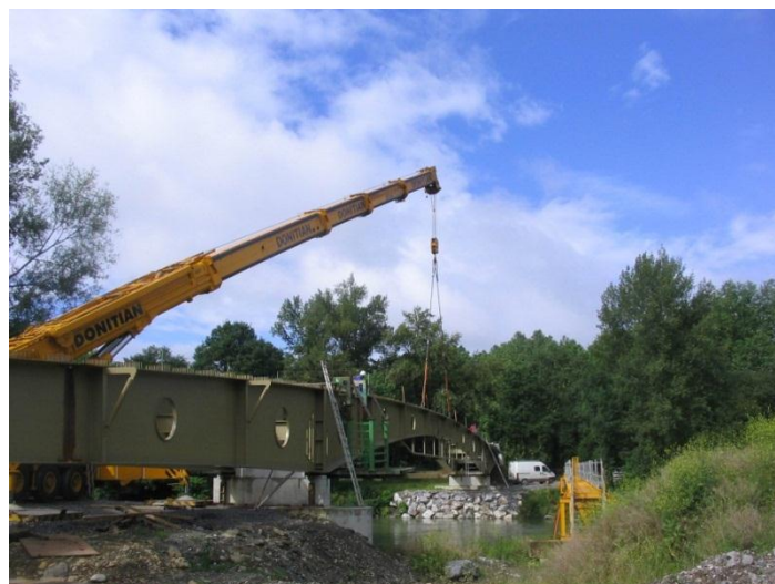
Figure 29 : Pose de la passerelle métallique sur le Gave, Archives communautaires Pau-Pyrénées, 17 NUM 2
