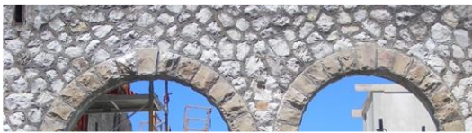
Figure 6 : appareil de moellons et de pierres irrégulières, Archives communautaires Pau-Pyrénées
