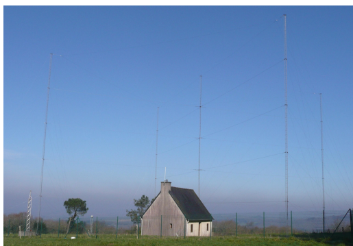
Illustration 3: Station DGPS IALA de Pont de Buis (ID:462)
