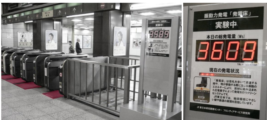
Fig. 22 Energie piézoélectricité dans le métro à Tokyo (Japon)
