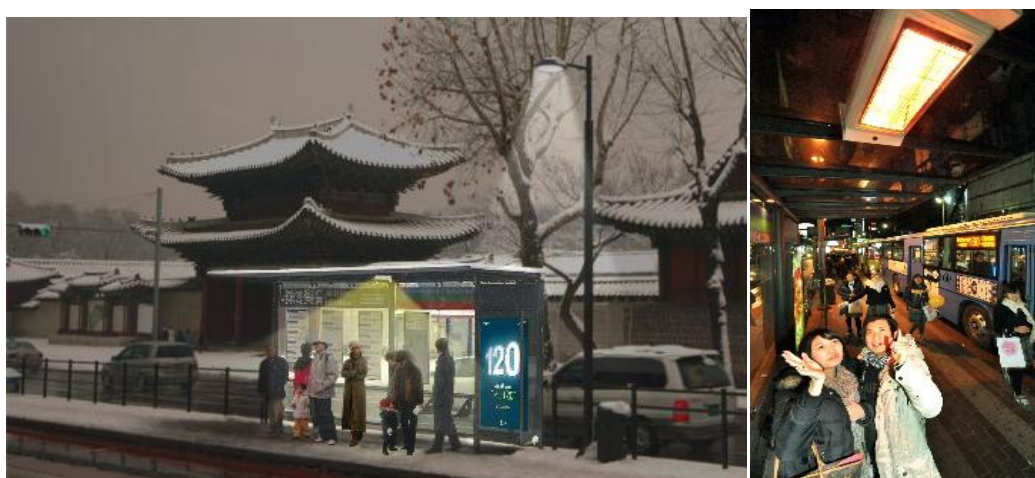
Fig. 14 Arrêt de bus avec chauffage infrarouge
