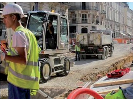
Chantier du tramway, avenue Jeanne d'Arc
