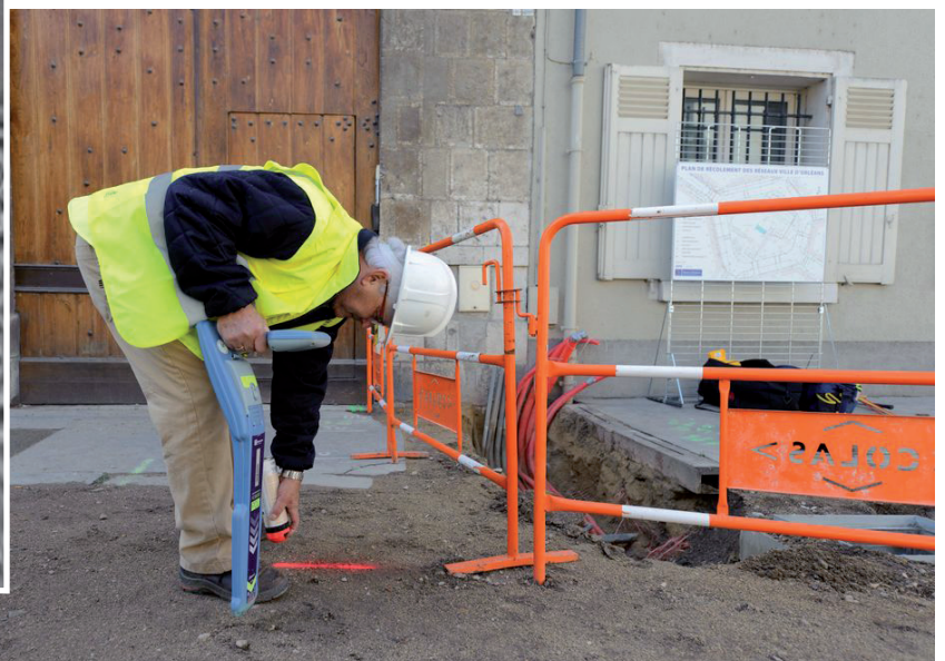
Détection de réseaux par méthode électromagnétique, rue de la Bretonnerie
