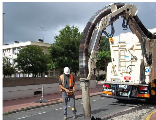
Investigations complémentaires et utilisation d'une aspiratrice par l'Orléanaise des Eaux, allée Anne du Bourg
