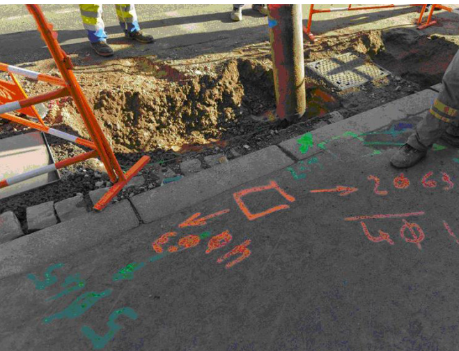
Exemple de marquage-piquetage
