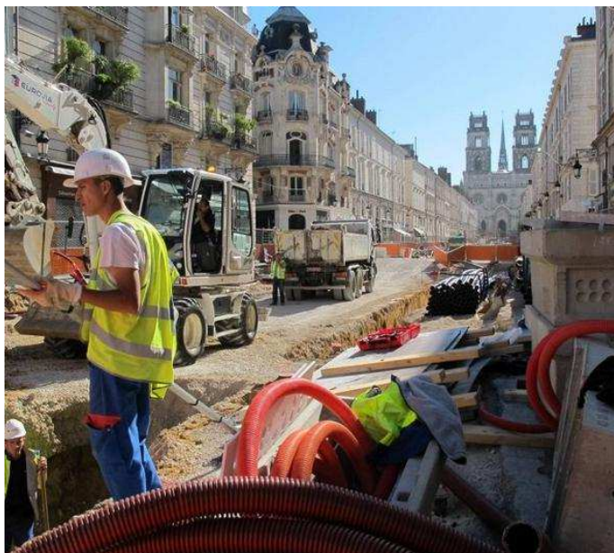
FIGURE 20: ENFOUISSEMENT DE RÉSEAUX LORS DES TRAVAUX DU TRAMWAY, RUE JEANNE D'ARC
