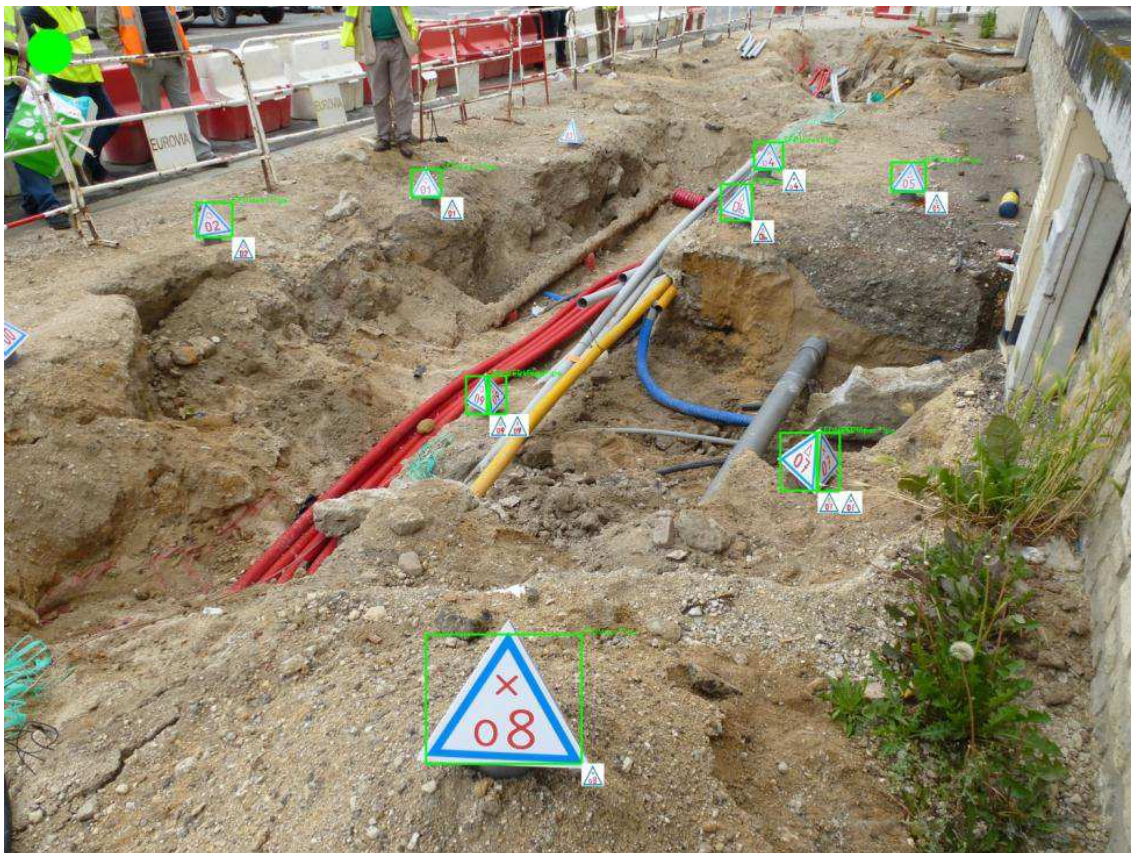
FIGURE 17: DÉMONSTRATION DU PROCESSUS PHOTOGRAMMÉTRIQUE DE FIT-ESIC SUR DES FOUILLES OUVERTES
