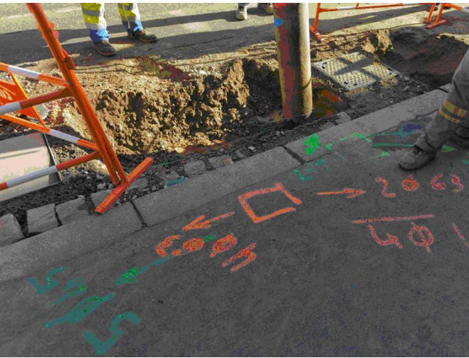
Exemple de marquage-piquetage
