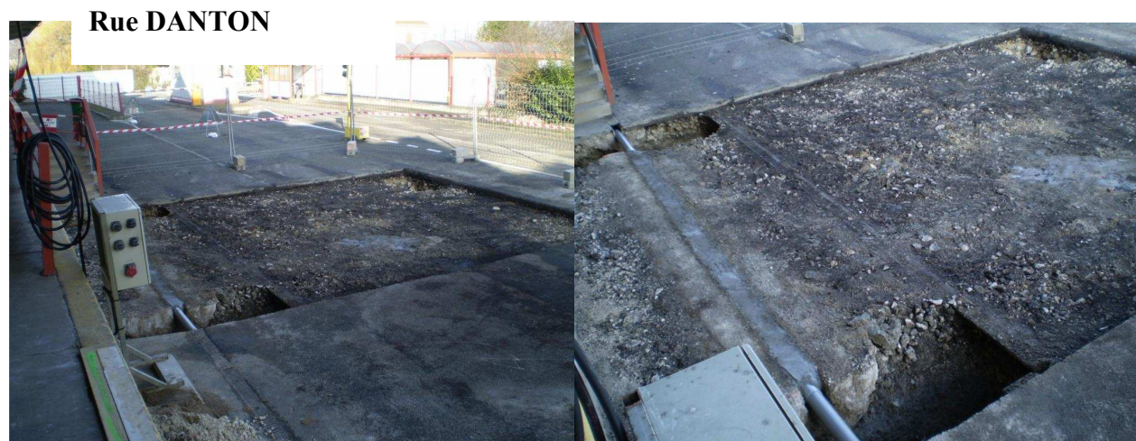
Figure 15 – découverte de la voie ferrée.
