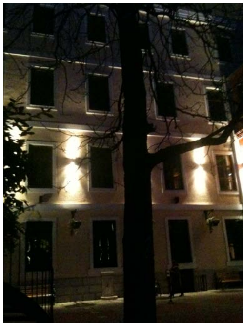
b) Vue cour intérieure de nuit n° 636
