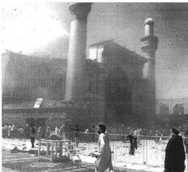
Sobre estas líneas, una imagen del exterior de la mezquita de Alí instantes después de la explosión.
