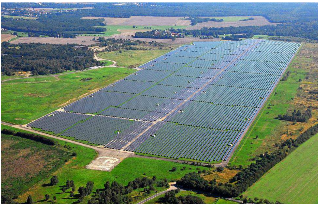
Photographie 7 : La centrale photovoltaïque de Waldpolenz en Allemagne
