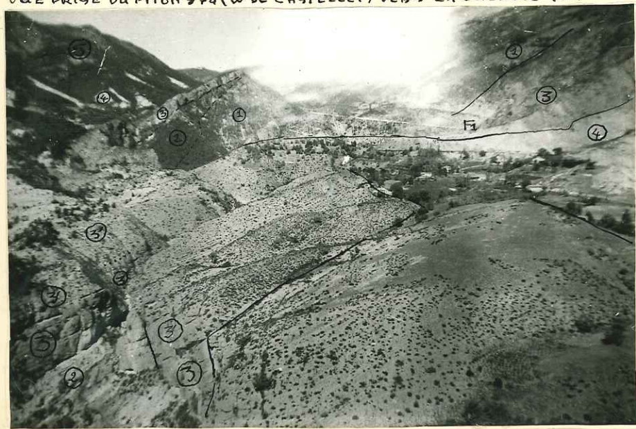
VUE PRISE DU PITON 974 (W DE CASTELLET) VERS LA CULASSE (N)
