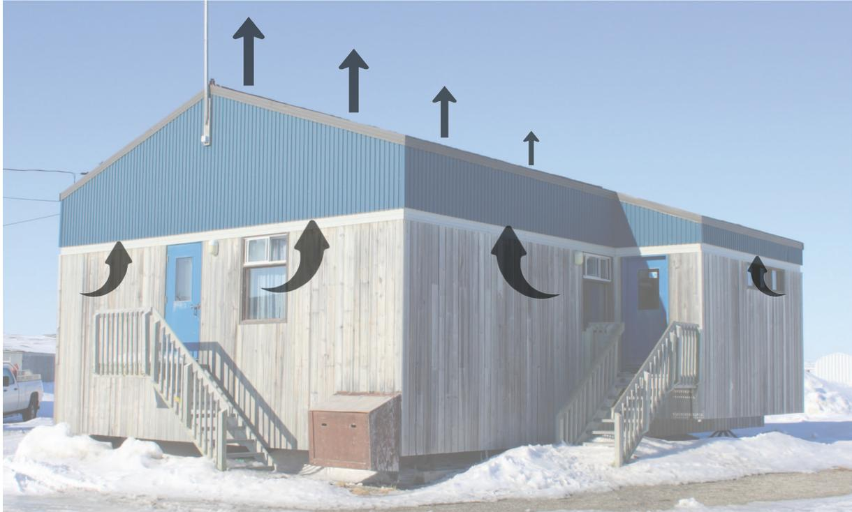
Aspiration de l'air sous le parement de tôle et le filtre média bloquant la poussière de neige et évacuation de l'air au faîtage. Source : Photographie durant le voyage à Akulivik en mai 2013.
