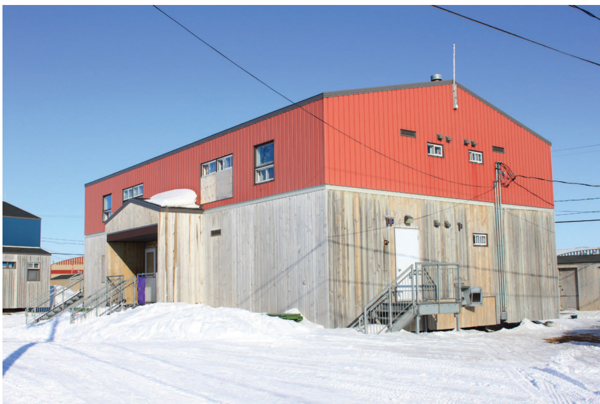
Logement de type « M6 », conçue par la SHQ. Source : Photographie de Emmanuelle Déjos, Akulivik, mai 2013.
