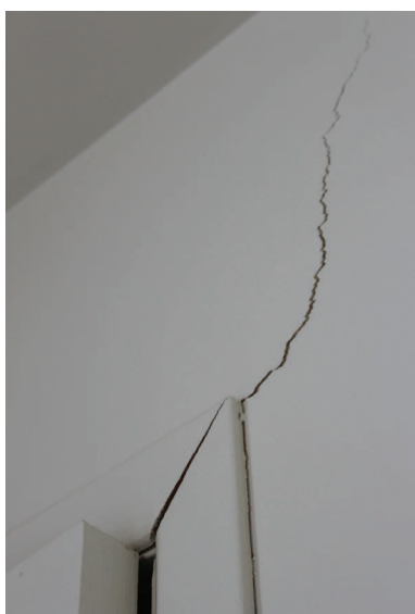
Des cas fréquemment rencontrés lors de nos visites d'habitats : fissures dans les panneaux de plâtre, abaissement du plancher, etc. Source : Photographie durant le voyage à Akulivik en mai 2013.
