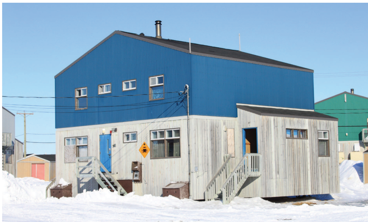
Logement de type « J2.2 », 1991, conçue par la SHQ. Source : Photographie de Emmanuelle Déjos, Akulivik, mai 2013.
