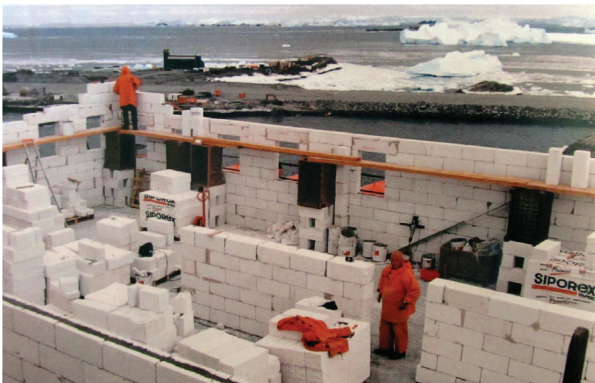
Construction d'un édifice en béton cellulaire. Source : Institut Polaire Français Paul Emile Victor, Observatoire Dumont d'Urville, Descriptif et présentation de la station.
