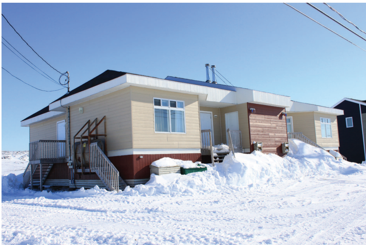
Habitation jumelée conçu pour les enseignants d'Akulivik. Des volumes se détachent du volume général, les façades sont teinté de différentes couleurs...
