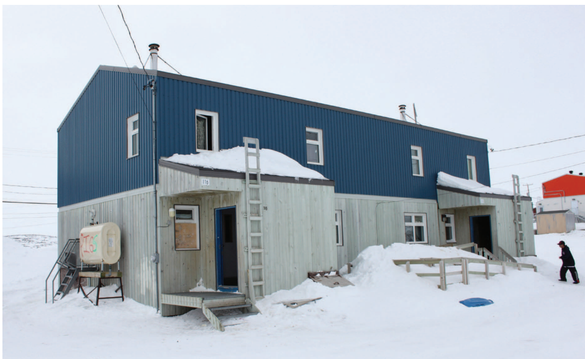
Logement de type « J2.4 », conçue par la SHQ. Source : Photographie de Emmanuelle Déjos, Akulivik, mai 2013.
