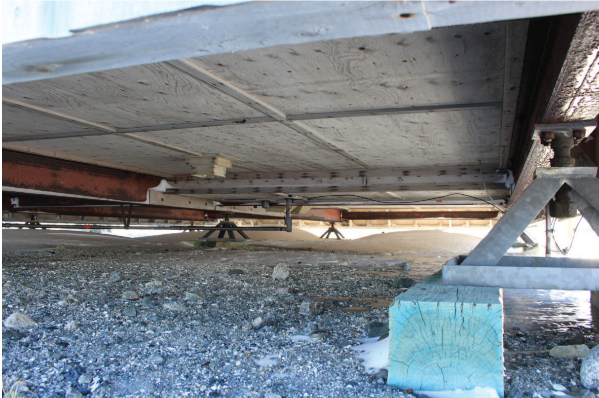
Verrins métalliques ajustables sous un logement. Source : Photographie durant le voyage à Akulivik en mai 2013.
