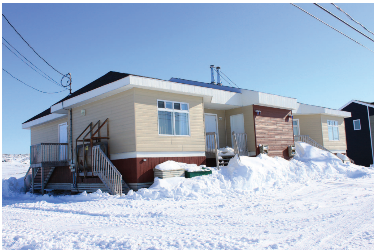
Habitation jumelée conçu pour les enseignants d'Akulivik. Des volumes se détachent du volume général, les façades sont teinté de différentes couleurs...
