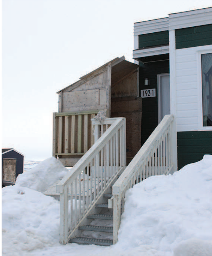
Ici, l'habitant a construit un cabanon avec des planches de bois récupérées afin de créer une extension au porche. Logement J2.2. Source : Photographie de Emmanuelle Déjos, Akulivik, mai 2013.
