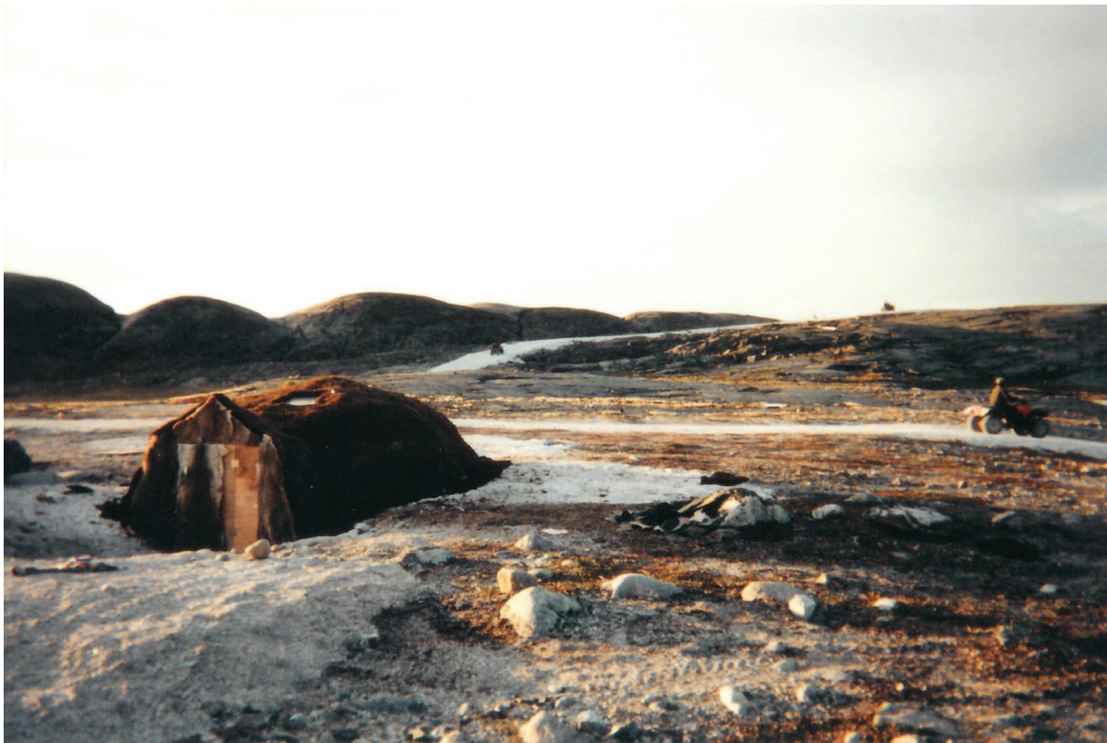
Photographie d'un « Qarmak », habitat de saison intermédiaire en bois et tourbe, reconstitué par les habitants d'Akulivik en août 2010. Source : Photographie d'Alain Mercier et Aline Carroll
