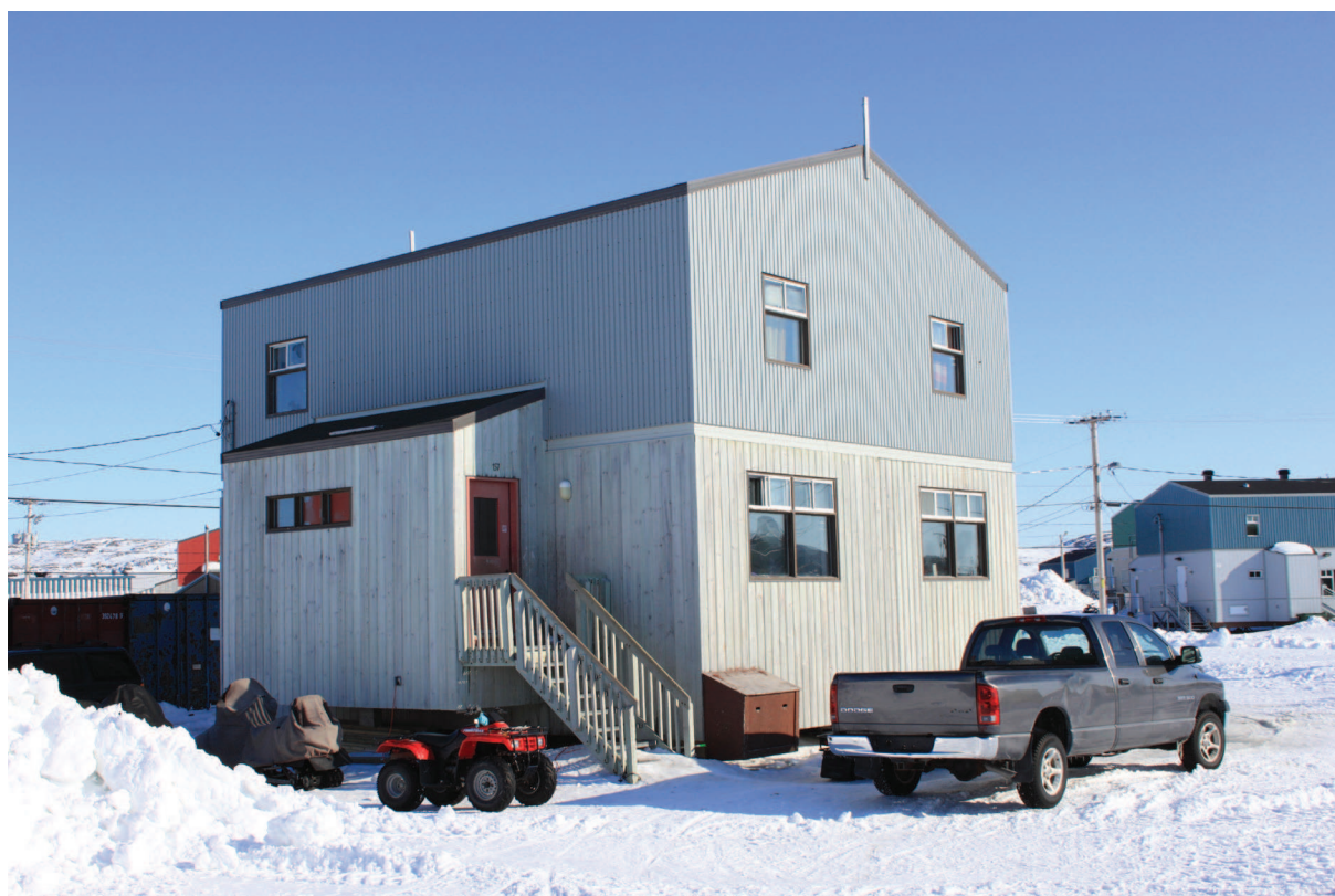
Logement de type « U3 », conçue par la SHQ. Source : Photographie de Emmanuelle Déjos, Akulivik, mai 2013.
