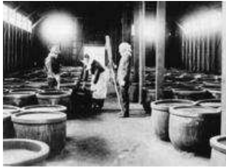
Figure 35 : Hydrolyse utilisant les poteries Domyogi-game dans l'industrie Zushi (Japon). La farine de gluten était placée dans un Domyogi game puis l'acide chlorhydrique y était ajouté. La suspension était mélangée et chauffée pendant 20 heures pour provoquer l'hydrolyse. Les Domyogi-games ont été fabriqués à Tokoyame (Japon). Tokoyame était très réputé pour la production de matériel en céramique à partir d'argile locale. Cette argile permettait la production de pots en céramique qui étaient très résistants à l'acide et aux hautes températures 65
