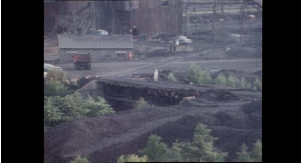
Wanda (4'21) : Wanda au milieu du chantier.
