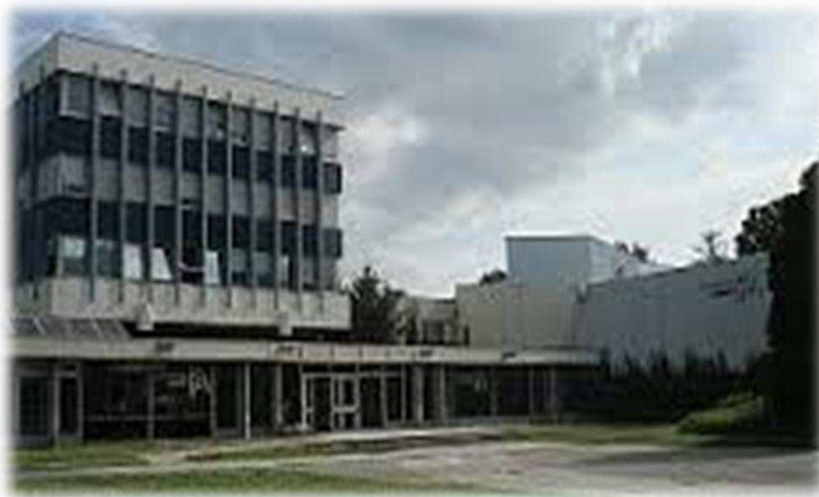
Figure 1. Le site Ampère du laboratoire GIPSA-Lab
