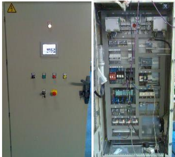
- Figure 55: Comparaison entre la phase d'étude et la réalisation de l'armoire générale XG1 -
