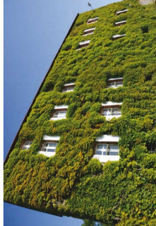
Moulin Gautron : véritable emblème du site avec sa façade entièrement végétalisée
