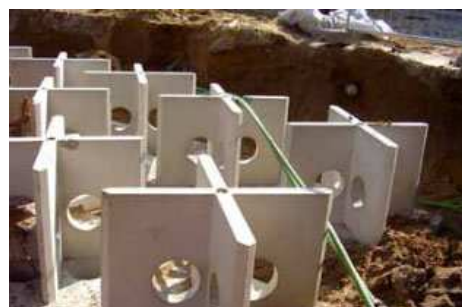
Figure 31: Photographie de la mise en œuvre de modules béton 'Deuxième sol naturel' développés par la pépinière Van Den Berk (Source : vdberk.fr 2014)
