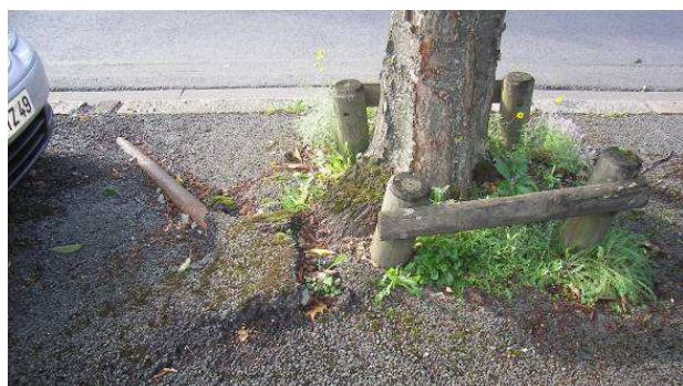
Figure 4 : Photographie d'une racine charpentière* de cerisier soulevant le revêtement bitumineux du trottoir Rue Jacques Bordier - Angers (49). (Gouédard, 2014)
