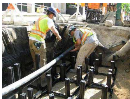
Figure 30 : Photographie et détail technique des modules Silva Cell développés par DeepRoot. (Source : GreenMax.fr 2014)
