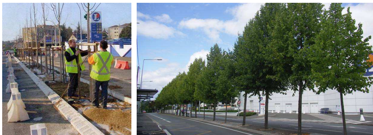
Figure 28 : A gauche, photographie d'une plantation réalisée avec fosse en tranchée continue à Angers, rue de la Meignanne (ALM, 2001). A droite, photographie de l'alignement actuel (Gouédard, 2014).
