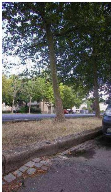
Figure 26 : Photographie d'une racine de Platane soulevant le revêtement de voirie (Place de la Dauversière à Angers), faute de disposer d'un volume de terre suffisant pour se développer. (Gouédard, 2014)
