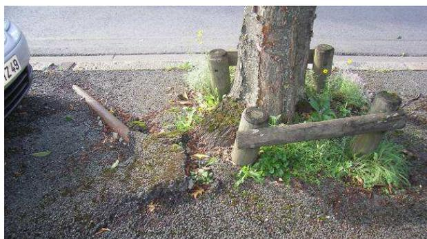
Figure 4 : Photographie d'une racine charpentière\* de cerisier soulevant le revêtement bitumineux du trottoir Rue Jacques Bordier - Angers (49). (Gouédard, 2014)
