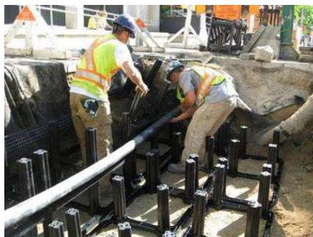
Figure 30 : Photographie et détail technique des modules Silva Cell développés par DeepRoot. (Source : GreenMax.fr 2014)
